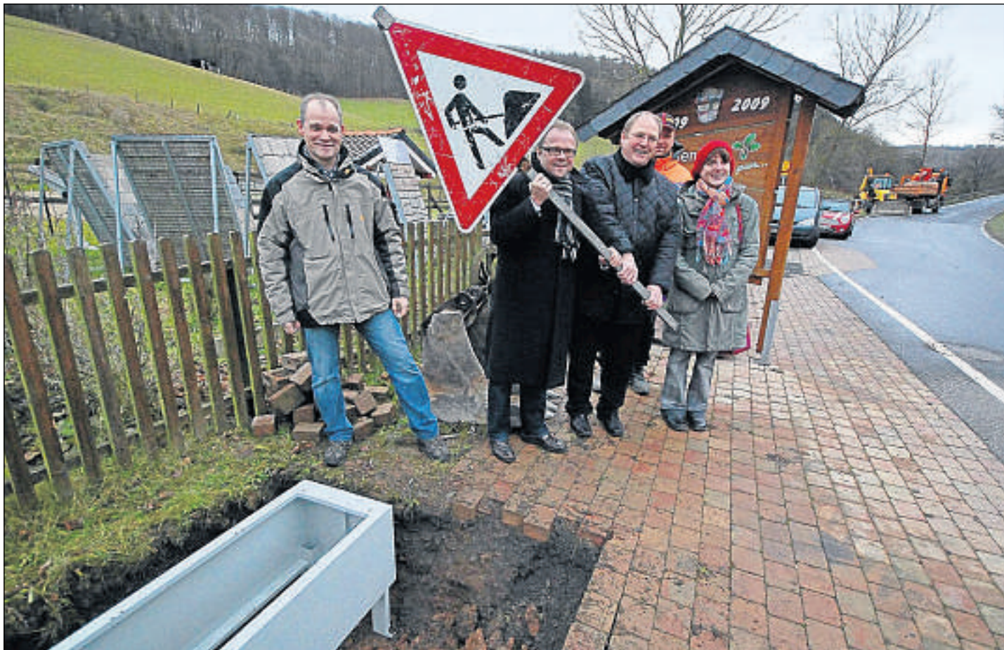
Vorsicht Baustelle: Am Ortseingang von Kehrenbach werden die Glasfaserleitungen an das bestehende Netz angeschlossen. Max Roosen (OR Network, von links), Bürgermeister Dieter Runzheimer, Günther Schmoll und Katja Baier (OR Network) besuchten am Dienstag die Baustelle.
